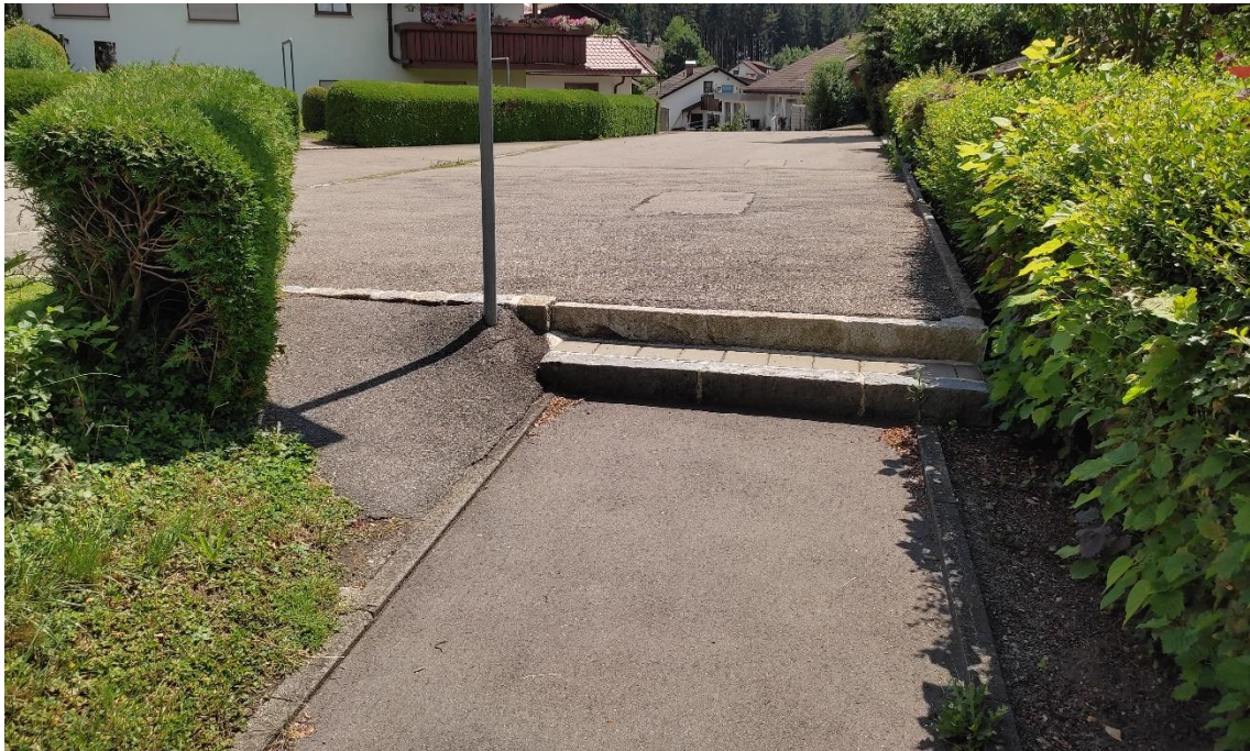
Abbildung 36: Stufen Richtung Starenweg
