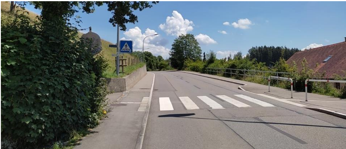
Abbildung 12: Eingeschränkte Sichtbeziehungen durch Seitenraumbegrünung
