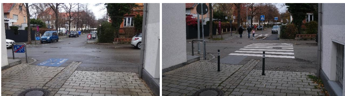
Abbildung 2: Umgesetzter modaler Filter in Metzingen
