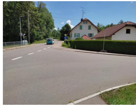
Abbildung 8: Querung entlang der L 335
