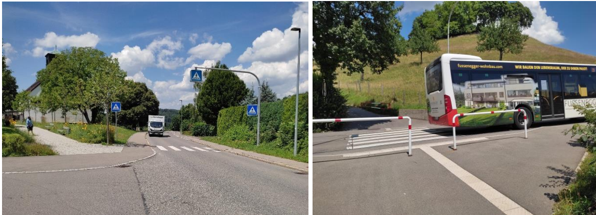
Abbildung 6: Blindenleitsystem und abgesenkte Bordsteine
