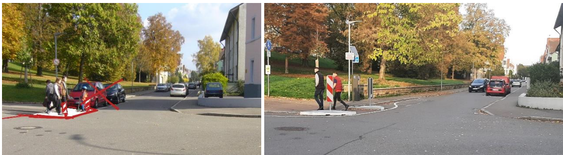
Abbildung 1: Umgesetzte Gehwegnase in Singen
