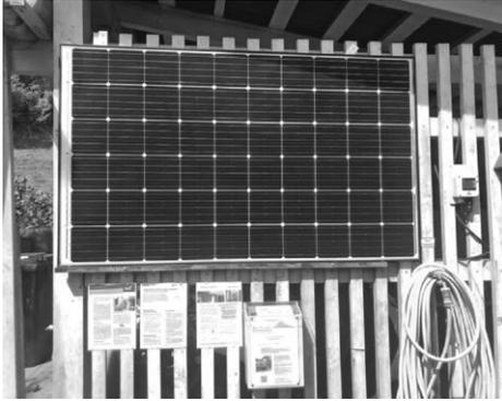
Solare Mini-Kraftwerke erzeugen netzkonformen 230 Volt Wechselstrom, den Sie direkt in Ihr normales Hausnetz einspeisen können. Die Montage der Solarmodule incl. Wechselrichter erfolgt an einer sonnigen Stelle. Zum Beispiel: Dach, Hausfassade, Balkonbrüstung, Terrasse.
