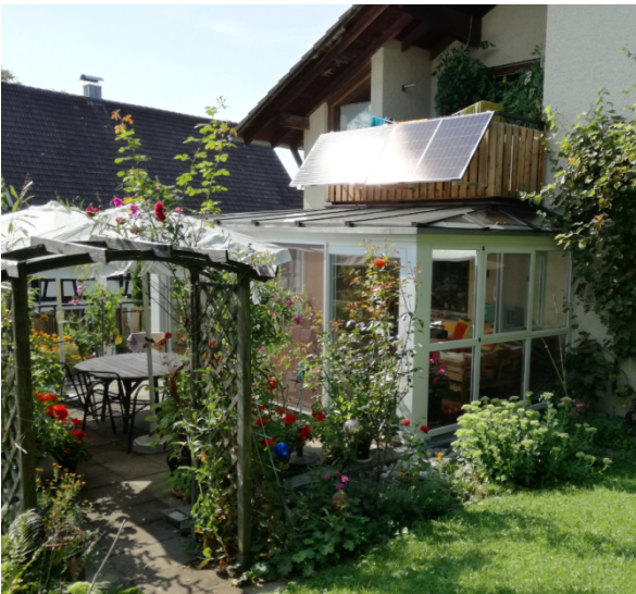
Balkonkraftwerk in Bodnegg
