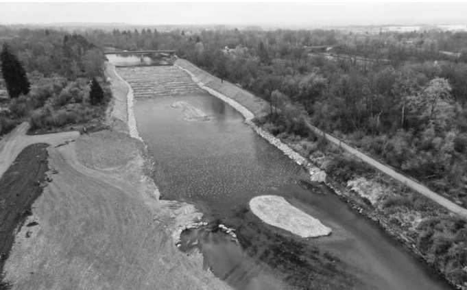
Drohnenaufnahme mit Blick nach Süden; Fotografie: Regierungspräsidium Tübingen, Landesbetrieb Gewässer. Die Betonschwelle in der Iller auf Höhe des Autobahnzubringers B 312 bei Heimertingen wurde erfolgreich zu einer sogenannten
