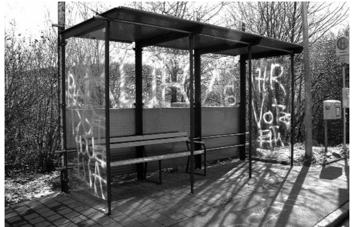
Buswartehäuschen in Rosenharz - Sachbeschädigung durch Graffiti-Schmierereien
